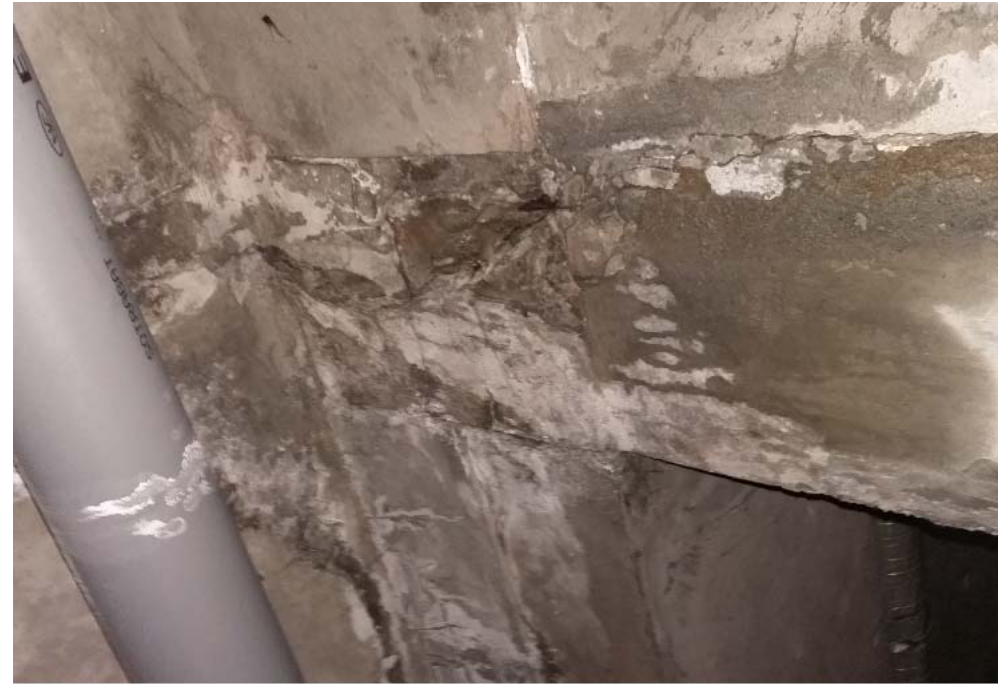
Constat suite aux sondages effectués pour déterminer la consistance de la protection sur étanchéité et constat de traces des infiltrations d'eau en sous face
