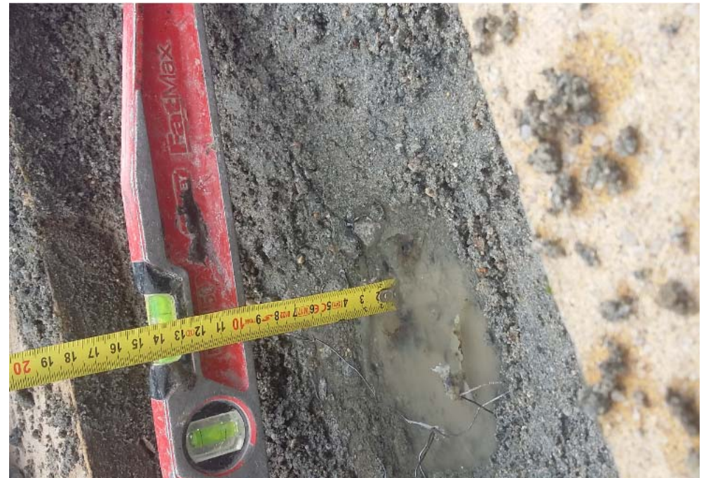
Constat suite aux sondages effectués pour déterminer la consistance de la protection sur étanchéité
