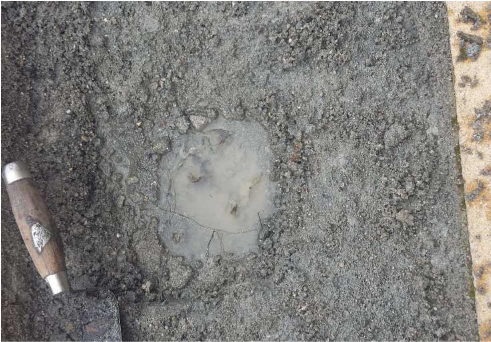
Constat suite aux sondages effectués pour déterminer la consistance de la protection sur étanchéité et constat de traces des infiltrations d'eau en sous face
