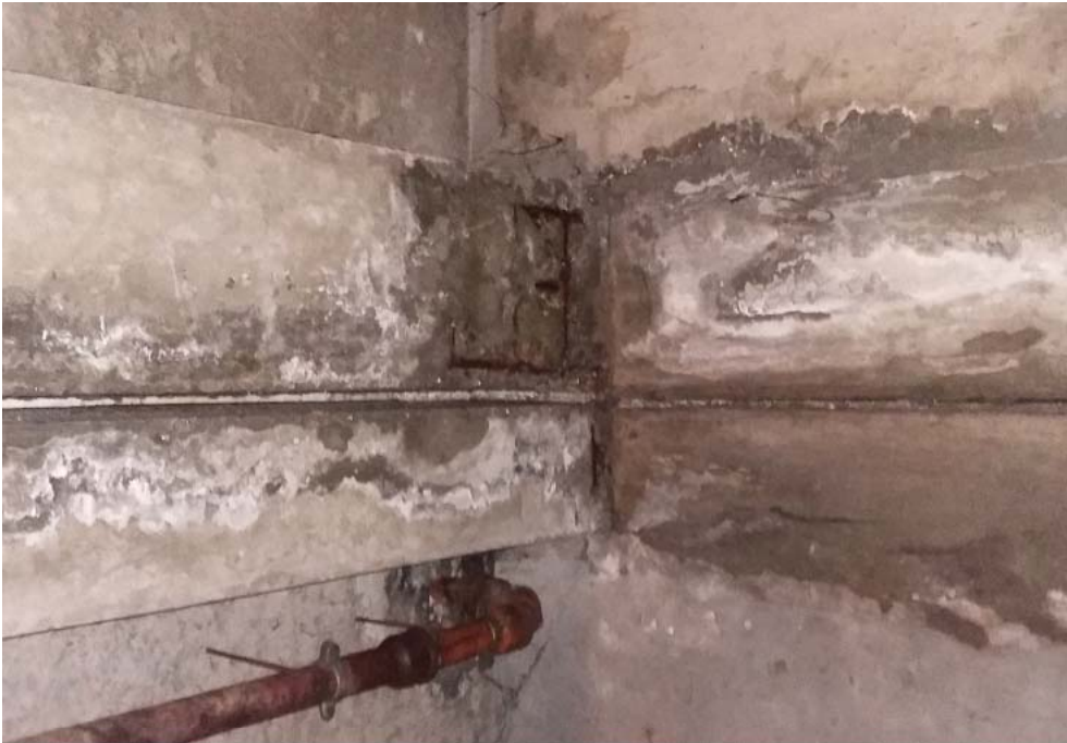
Constats des infiltrations en sous face
