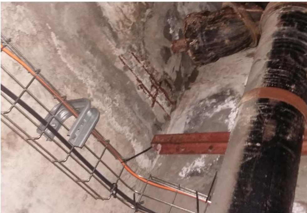
Constats des infiltrations en sous face et des béton éclatés par les aciers corrodés par ces infiltrations
