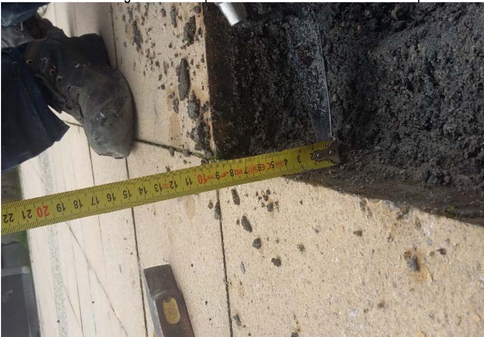
Constat suite aux sondages effectués pour déterminer la consistance de la protection sur étanchéité
